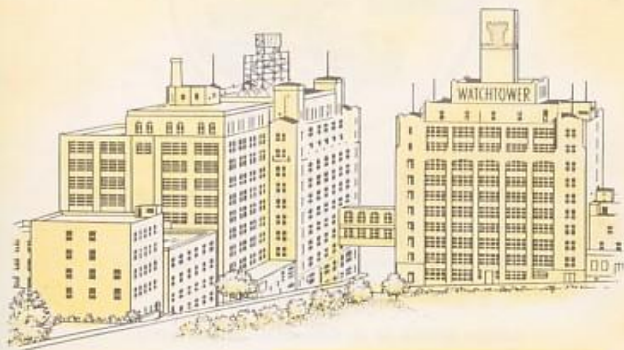
Edificios para envío y almacenaje, Brooklyn, N.Y.
